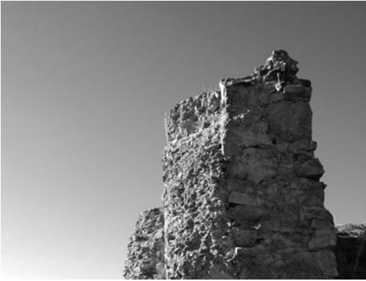
Figura 6 Vista en sección del estribo izquierdo de la pantalla (Arenillas et al. 2009)
