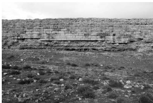
Figura 5 Revestimiento de opus quadratum conservado en el estribo izquierdo (Arenillas et al. 2009)
