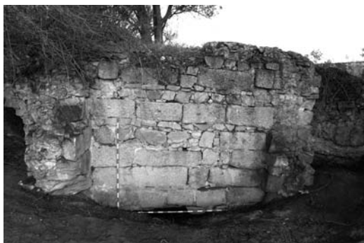
Figura 3 Fragmento superior de la pantalla con arranque de los muros de la torre del desagüe de fondo (Arenillas et al. 2009)
