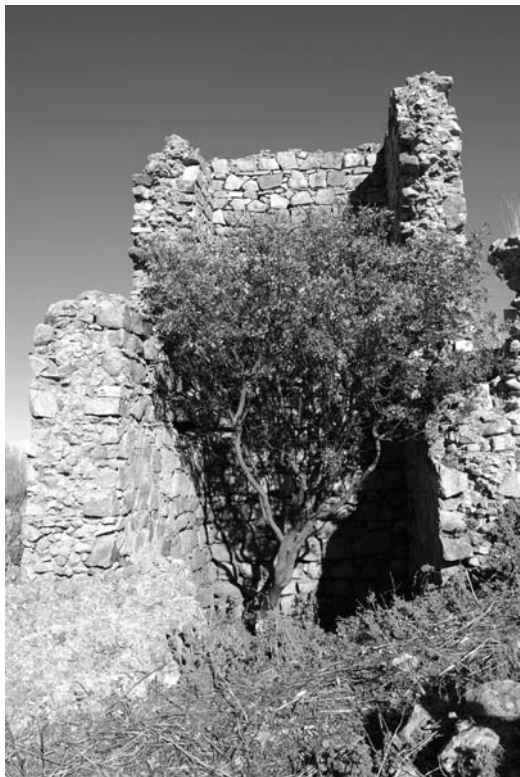
Figura 4 Torre de toma de la presa (Arenillas et al. 2009)
