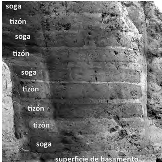
Figura 3 Detalle de corte perpendicular del muro perimetral con aparejo a sogas y tizón, segunda etapa constructiva, plataforma norte de La Joya (Foto Daneels, noviembre 2007)
