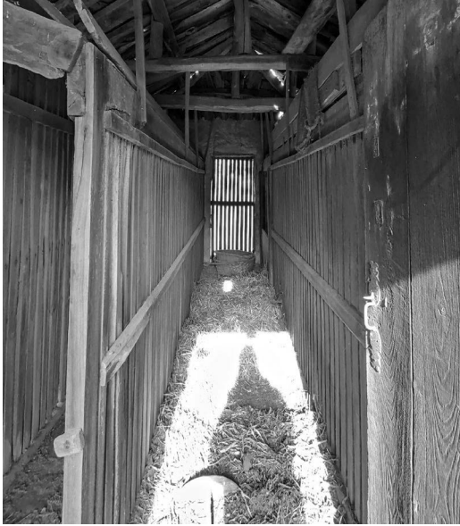
Figura 9 Interior del cabazo de Casa Agosto en Piñeira (Boal). Pasillo central con tabiquillos de duelas que lo separan de los espacios de almacenaje laterales. (Foto de los autores)
