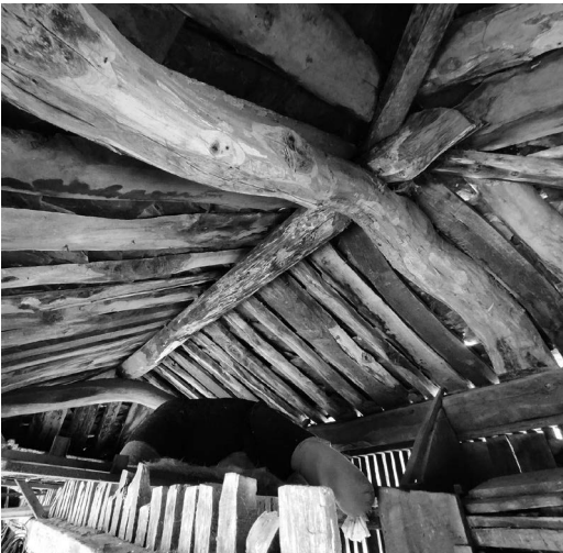
Figura 12 Vista interior de la cubierta de Casa Costa (Zadamoño), con las tixeras , el curume apoyado sobre ellas, los aguilóis que forman el cambio de faldón, y los pontóis que conforman los faldones. (Foto de los autores)
