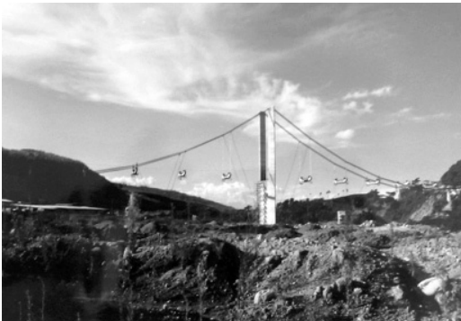
Figura 9 Vigas transversales colgadas de las catenarias. Fuente: colección particular.
