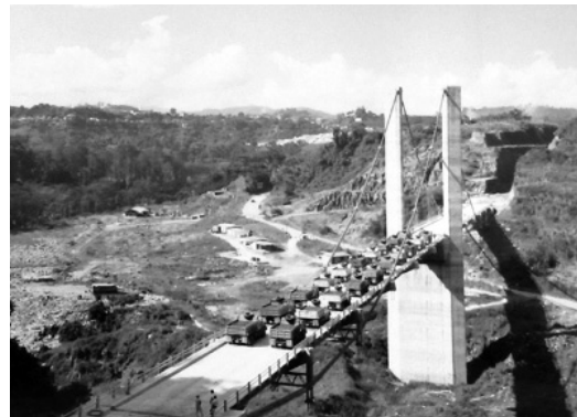
Figura 15 Prueba de carga sobre el puente. Fuente: colección particular.
