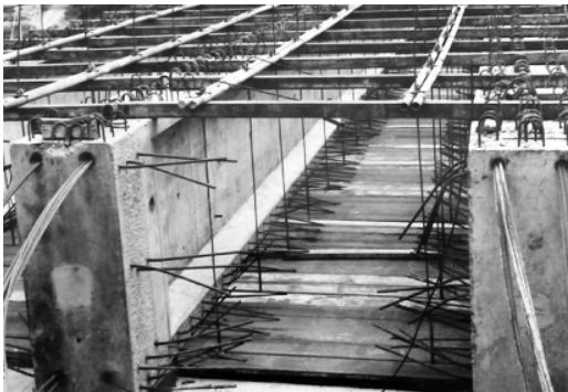
Figura 13 Posicionado de las vigas longitudinales mediante estructura auxiliar. Fuente: colección particular.
