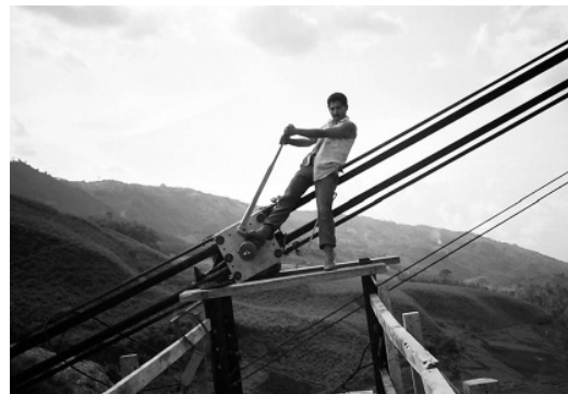
Figura 7 Colocación de la catenaria y abrazaderas sobre marcas hechas de manera previa, gracias a la plataforma deslizante. Fuente: colección particular.
