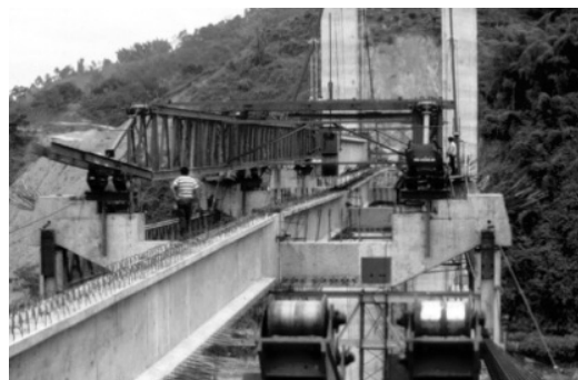
Figura 12 Posicionado de las vigas longitudinales mediante estructura auxiliar. Fuente: colección particular.
