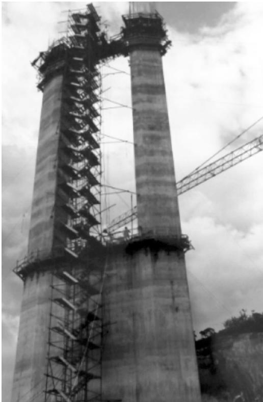
Figura 6 Pila central única, en proceso de ejecución. Fuente: colección particular.
