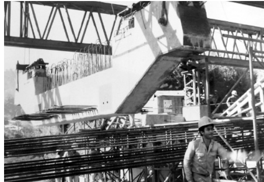
Figura 11 Lanzamiento de vigas transversales de los ejes 1, 2, 11 y 12. Fuente: colección particular.
