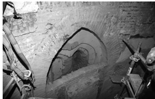
Figura 5 Ventana oculta del lado de la epístola y pilastra añadida en el cuerpo inferior del ábside. Intervención 2010. (Archivo propio)
