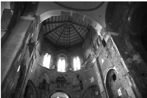
Figura 11 Sistema de ventanas inferiores y superiores. Intervención 2010. (Archivo propio)
