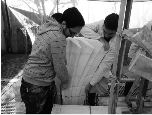
Figura 9 Las jarjas de esta bóveda alcanzan una altura superior a la mitad de su altura (foto autores).
