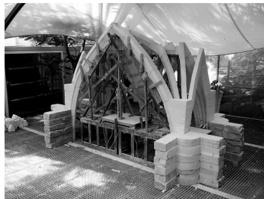
Figura 15 Fachada de la bóveda sobre su cimbra mostrando la gran arcada de las arquivoltas (foto autores).
