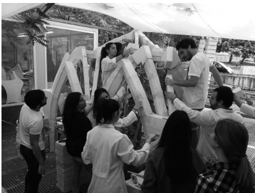
Figura 13 Montaje de los arcos terceletes de la bóveda (foto autores).
