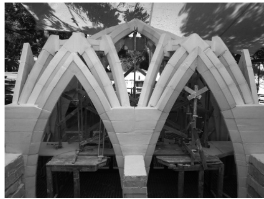
Figura 14 La interesante estructura de terceletes de la bóveda (foto autores).
