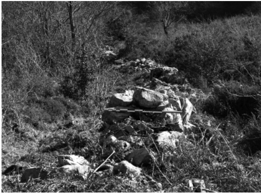
Figura 9 Restos de la pared de mampostería del Caón de Ladines (foto JP Torrente).
