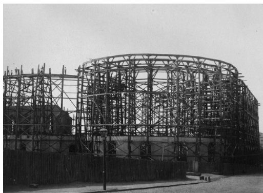
Figura 9 Andamios en construcción desde la calle Juan de Mena. 1889. Biblioteca de la Bolsa de Madrid
