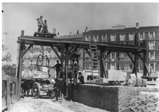
Figura 4 Vista de la grúa de descarga de materiales. 1887. Biblioteca de la Bolsa de Madrid
