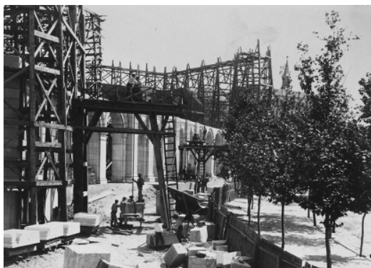
Figura 8 Operación de descarga de sillares en la obra. 12 de septiembre de 1889. Biblioteca de la Bolsa de Madrid
