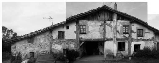
Figura 5 Fachada principal del caserío renacentista adaptada al estilo compositivo y técnica barroca: caserío Barrenetxea (barrio Uriona, Munitibar). Fuente propia.
