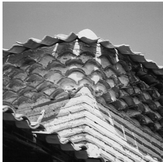
Figura 10 Alero de la Iglesia de San Juan de Olmedo (Camino 1988)
