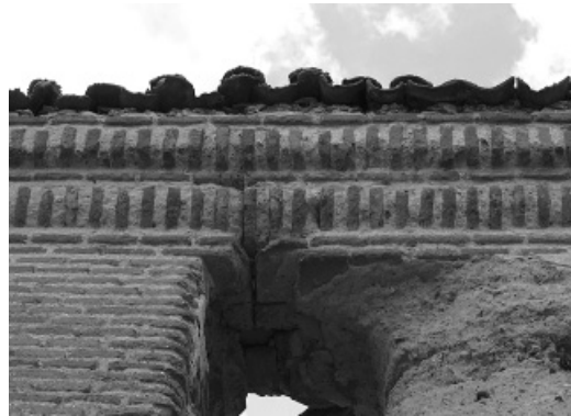
Figura 14 Alero de sardineles e hiladas del mismo edificio de la figura 13 (Autores 2017)
