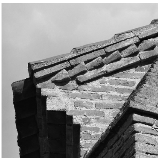
Figura 6 Alero de hilada a serreta en un hastial lateral de un edificio de vivienda en Serrada (Autores 2017)
