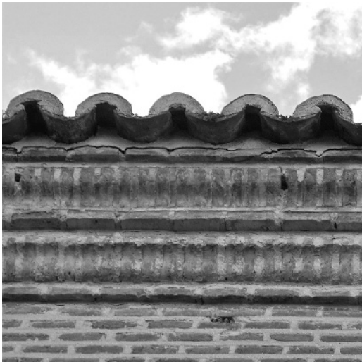
Figura 4 Alero de una Casona de Serrada formado por dos sardineles con ladrillos aplantillados (Autores, 2017)
