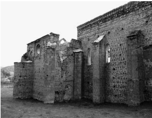
Figura 9 Exterior del crucero y la nave de la iglesia
