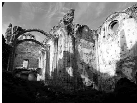
Figura 2 Interior del templo en su estado actual
