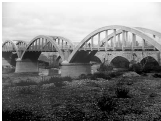
Figura 4 Puente de Peñafiel, sobre el Duero en Valladolid. Archivo Doña Carmen Villalba
