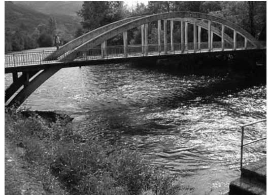
Figura 1 Puente sobre el río Narcea en Requejo, Asturias. Archivo autor
