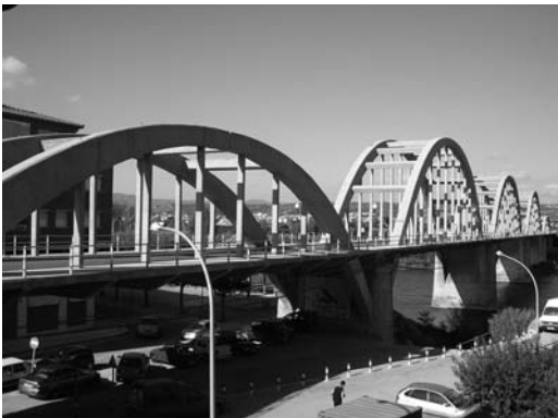
Figura 3 Puente de Mora de Ebro, sobre el Ebro en Tarragona. Archivo autor
