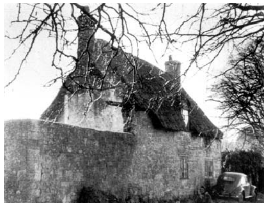
Figura 4 Vista desde el borde de la carretera que muestra el antiguo muro exterior mantenido como cerramiento norte del enclave. Edificaciones afectadas por una Orden de Derribo cuando se compraron; no obstante, la calidad del hastial del extremo, sugería que en verdad pertenecía a la granja de Beckford. Cuando se vació la antigua chimenea, los restos de al menos dos conflictos entre conducto de humos / cubierta de paja / viga de madera sugerían que hubo una granja en este lugar, al menos desde el siglo XV, fecha del granero; foto B. Richards. Pascua 1959» (Smithson y Smithson 1986)
