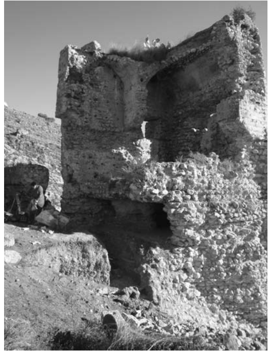
Figura 9 Vista de la Torre del Racó desde el suroeste
