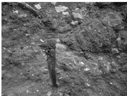
Figura 4 Improntas en la tapia de la cuña clavada en la tongada inferior y la cuerda que fijaba las tablas del encofrado.
