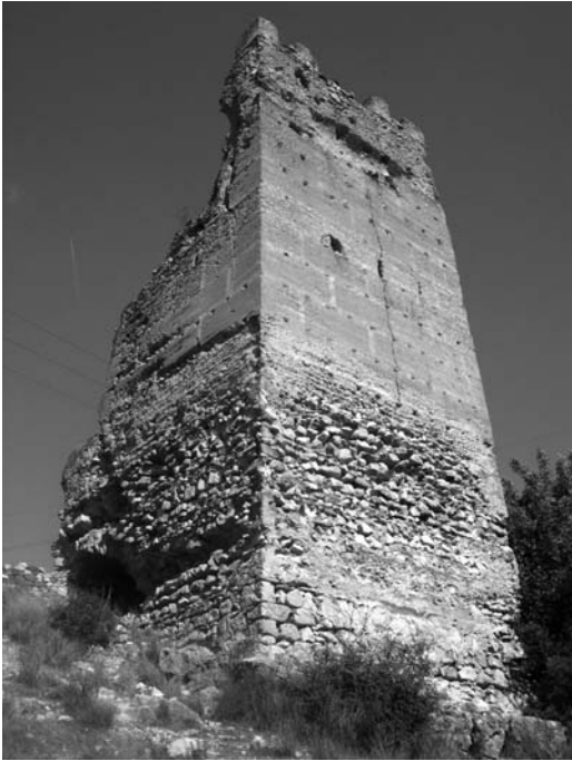
Figura 8 Torre del Castillo de la Pileta en Cortes de Pallás [Valencia]. Ejemplo de torre del período Almohade con restos de decoraciones simulando despieces de sillares
