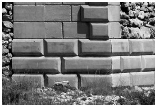
Figura 4 Fotografía donde se puede apreciar los sillares de piedra artificial empleados en el zócalo y las esquinas
