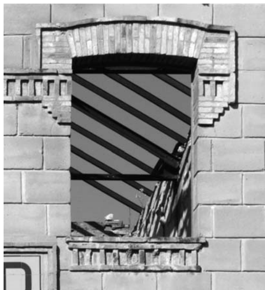
Figura 9 Fotografía del hueco tipo del cuerpo superior donde coexisten el bloque de hormigón con el ladrillo cerámico
