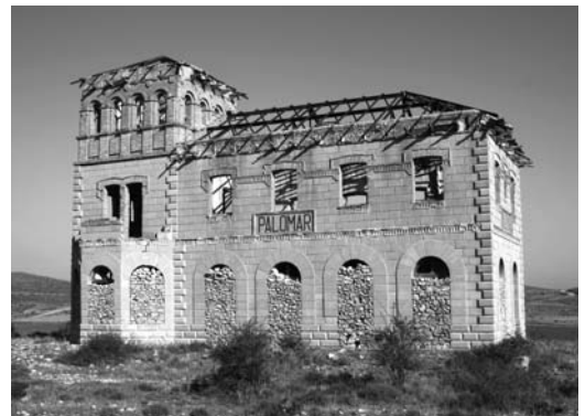
Figura 2 Fotografía del estado actual de abandono del edificio de viajeros de Palomar de Arroyos
