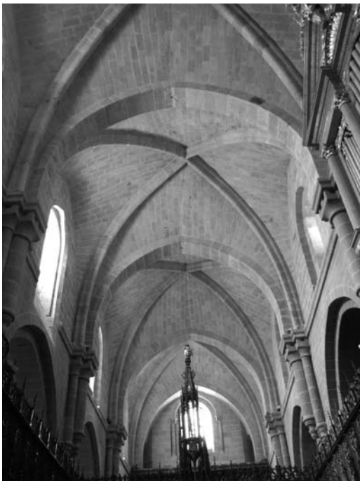
Figura 3 Bóvedas de la nave central de la Catedral de Zamora
