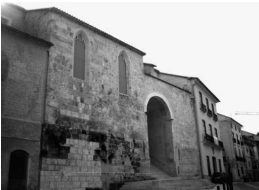
Figura 5 Entrada de la iglesia del convento después de las últimas restauraciones realizadas 2008
