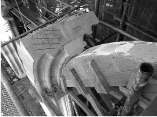
Figura 11 Detalle de la restitución de las dovelas del arco existentes en la obra junto con las que se realizaron de nuevo en una de las ventanas anexas a la puerta
