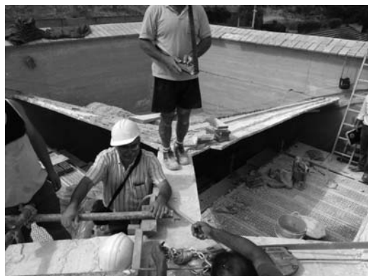
Figura 10 Detalle de la bóveda tabicada de la plementería
