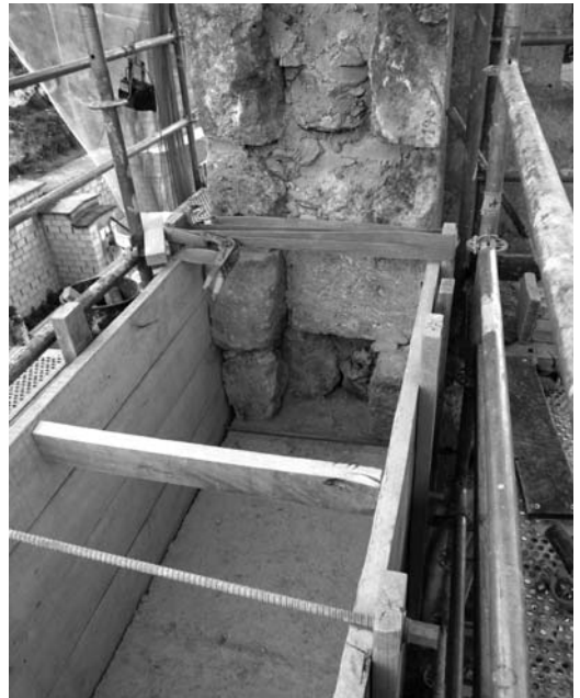
Figura 8 Detalle del tapial y de la fábrica de sillería de la esquina
