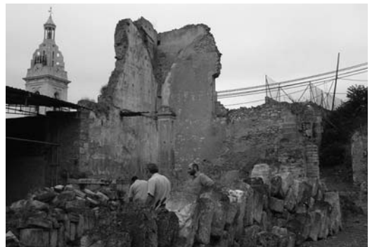
Figura 7 Imagen de los restos de la sala capitular en el inicio de las obras
