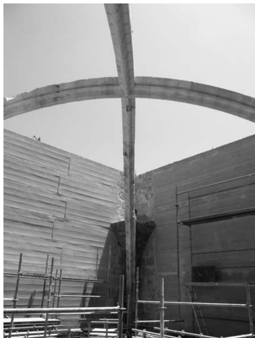
Figura 9 Detalle de los nervios de la bóveda de crucería una vez descimbrado
