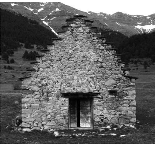
Figura 6 Hastial escalonado con penales en el paraje de Las Planas
