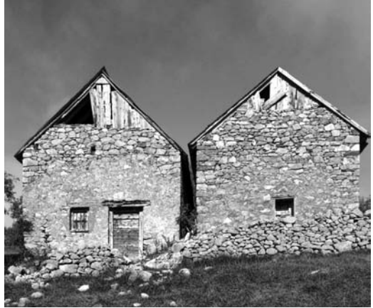
Figura 4 Bordas con hastial cerrado con tablazón de madera
