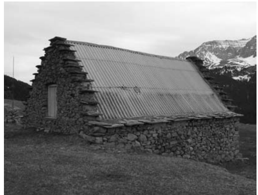
Figura 11 Vista de la borda en que se aprecia el acceso al pajar en la fachada norte
