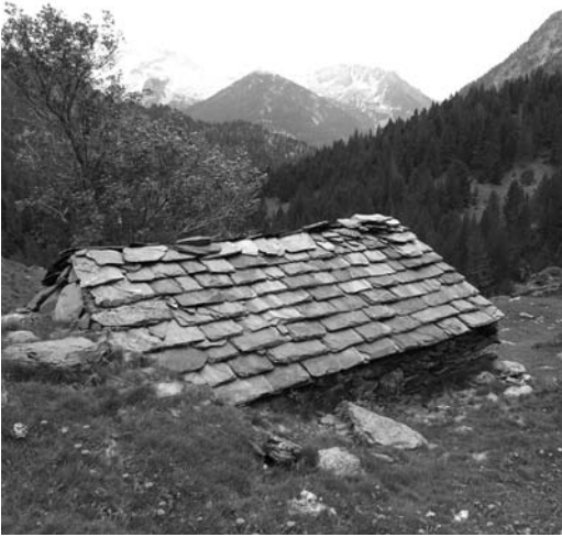
Figura 14 Vista de la cabana con la cubierta de losas de pizarra
