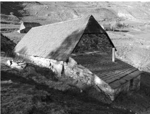
Figura 2 Cabana adosada a borda en la zona de Viadós
