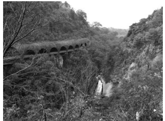
Figura 19 El moderno Túnel-Viaducto «Pensil»
