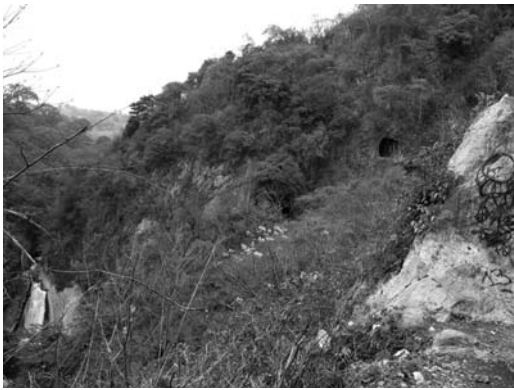
Figuras 17–18 Túnel nº 2 con el Salto del Atoyac
