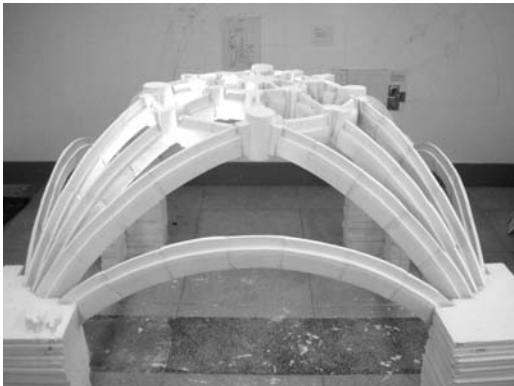
Figura 14 La bóveda ya descimbrada permite apreciar la esbeltez de sus nervios y la belleza de su diseño
