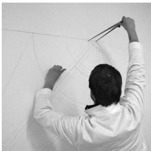
Figura 4 Dibujo de las monteas, la planta y sección de la bóveda a tamaño natural
