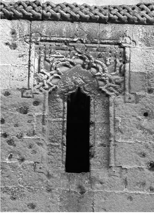
Figura 6 Ventana del cuerpo inferior. Fachada norte
