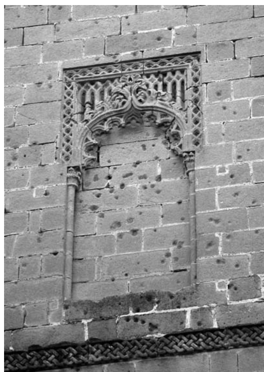
Figura 5 Ventana del cuerpo superior. Fachada este
