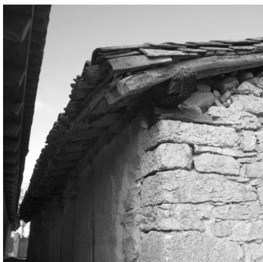
Figura 7 Vista de la fachada longitudinal de un pajar que da al callejón de separación de la vivienda. Se aprecia la solución constructiva de esta fachada en entramado de madera que contrasta con las otras tres fachadas, más expuestas, realizadas en piedra. (Fotografía de los autores)
