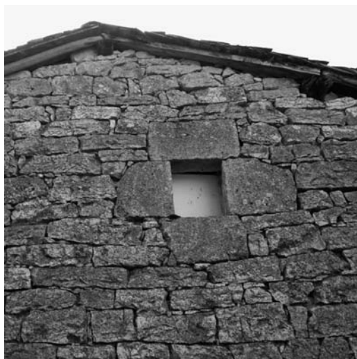
Figura 8 Hueco en el testero de un pajar en el que dintel, jambas y alféizar se definen utilizando cuatro sillares. La labra de las piedras es perfecta en la definición de hueco y de cierta irregularidad en su conexión con el resto de la fábrica. Se pueden apreciar las vigas longitudinales volando ligeramente sobre el paramento para definir un pequeño alero de protección. (Fotografía de los autores)
