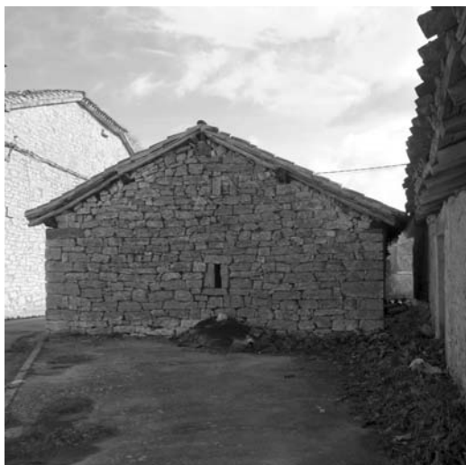
Figura 3 Vista de un pajar. Se puede apreciar su materialización como un volumen independiente aunque próximo a la vivienda. (Fotografía de los autores)
