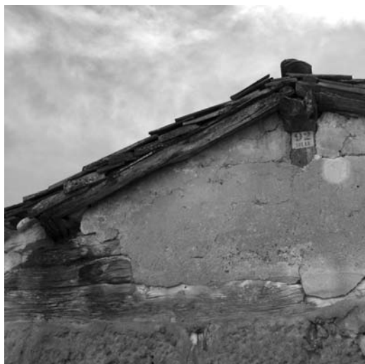
Figura 6 Detalle del hastial de un pajar realizado con entramado de madera. (Fotografía de los autores)
