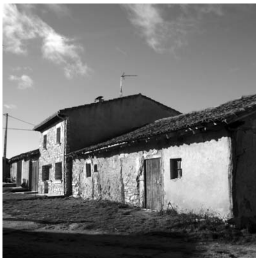
Figura 4 Sustitución de un pajar perteneciente a un conjunto en hilera por una vivienda de reciente construcción rompiendo la unidad funcional y formal de la manzana tradicional. (Fotografía de los autores)
