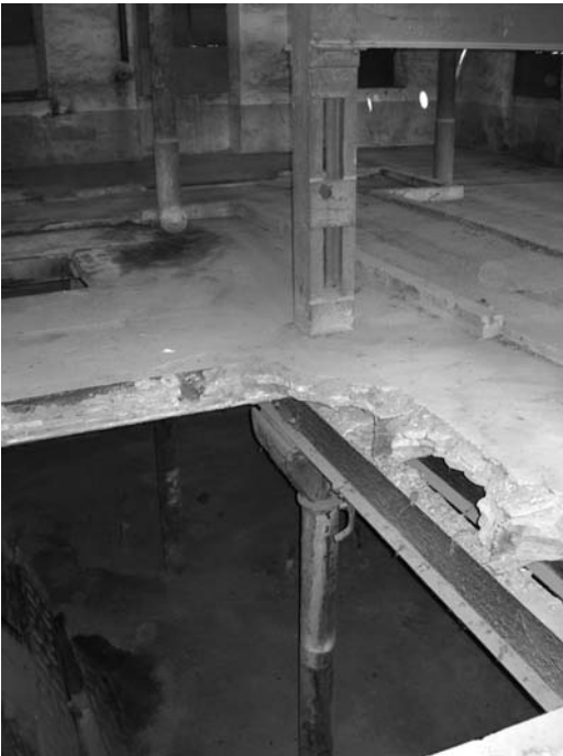
Figura 4 Prolongación de pilar con variación en la tipología
