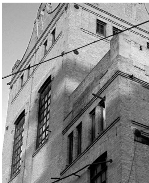
Figura 12 Refuerzos metálicos en la fachada de la Alcoholera de San Isidro
