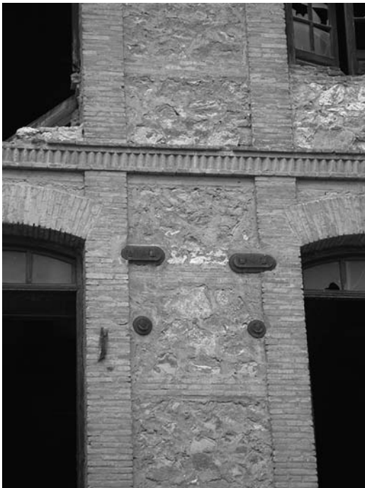
Figura 9 Detalle de anclajes de soporte del eje de transmisión horizontal
