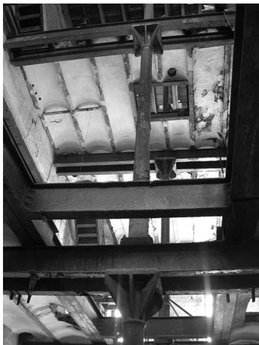
Figura 1 Pilares de fundición en la Fábrica de San Isidro
