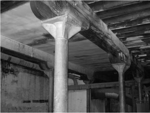
Figura 13 Pilares de fundición con capiteles en Nuestra Señora del Pilar (Motril)
