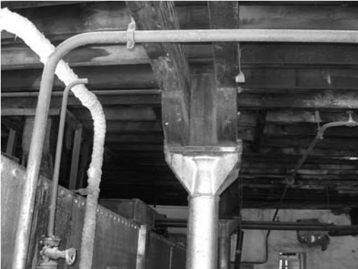
Figura 14 Detalle de prolongación de pilar entre plantas en Nuestra Señora del Pilar (Motril)
