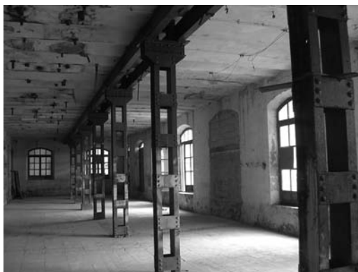
Figura 2 Pilares de perfiles de acero laminado en forma de «U» empresillados en la Fábrica de San Isidro
