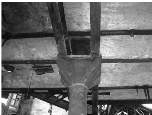
Figura 3 Detalle de prolongación de pilar
