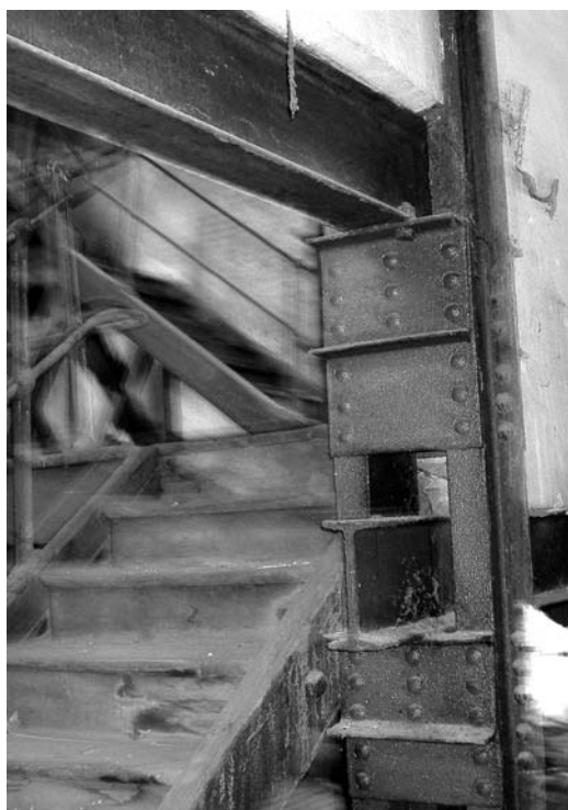
Figura 11 Pilares de láminas de acero en la Alcoholera de San Isidro
