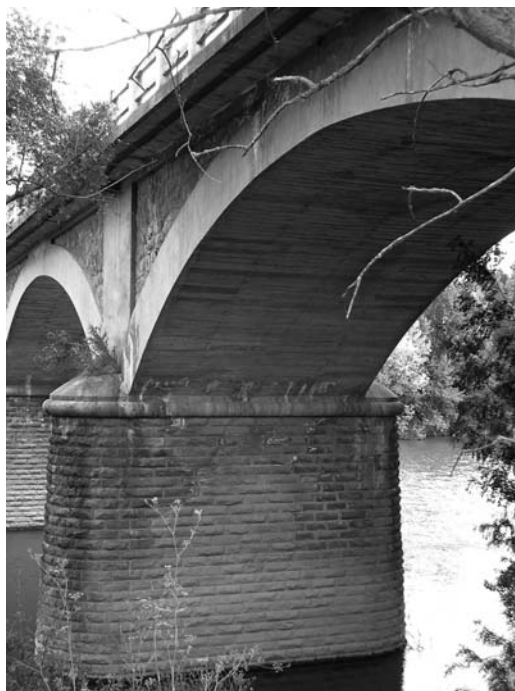
Figura 7 Puente de Baños de Ebro. Detalle de la bóveda. (Rubiato 2009)
