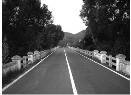
Figura 8 Puente de Baños de Ebro. Tablero. (Rubiato 2009)
