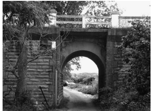
Figura 9 Puente de Baños de Ebro. Detalle bóveda del camino de sirga o tramo de avenidas
