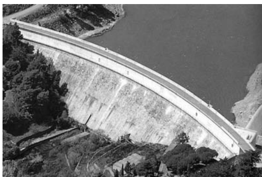
Figura 16 Vista aérea de la presa de Riudecañas (Ministerio de Medio Ambiente)
