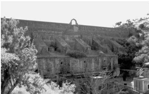
Figura 8 Vista desde aguas abajo de la presa de Albuhera de Feria
