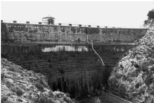
Figura 4 Vista de la presa de Almansa desde aguas abajo
