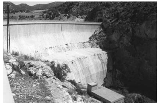
Figura 11 Vista de la presa de Valdeinfierno desde aguas abajo
