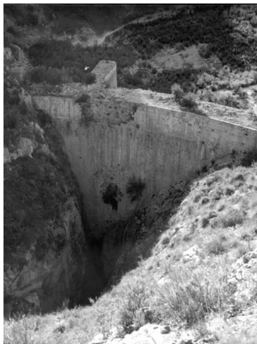
Figura 6 Vista de la presa de Rellou desde aguas abajo
