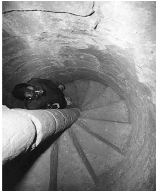
Figura 9 Vista del husillo
