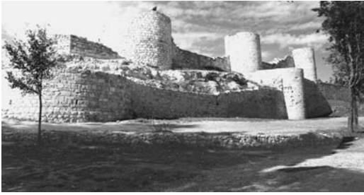
Figura 3 Estado actual del Castillo
