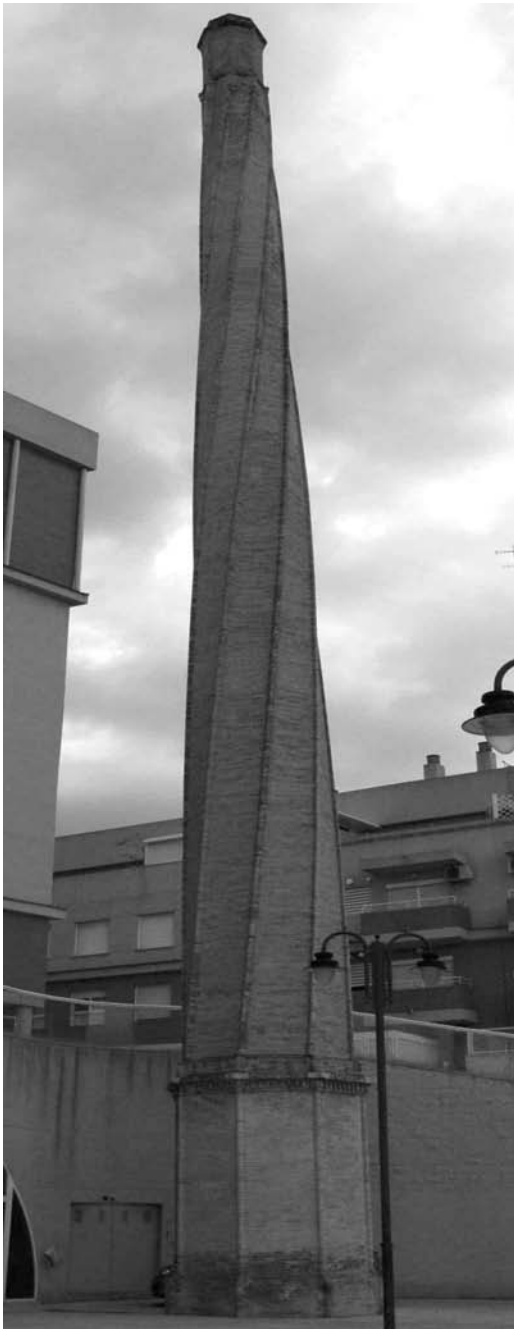
Figura 14 Chimenea helicoidal de la sociedad La Constructora, Alzira (Valencia)
