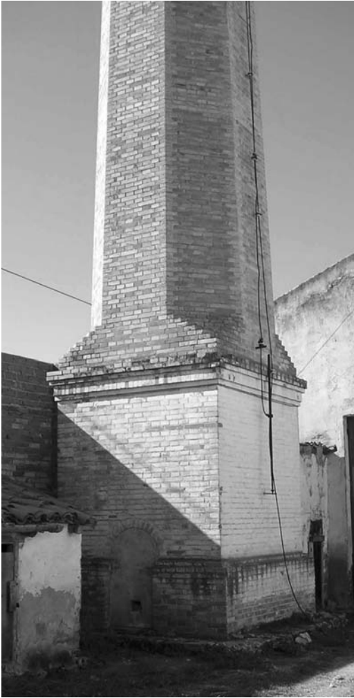
Figura 4 Base cuadrada chimenea Industrial Resinera Valcan, SA en Cuenca (autor: Laura Crespo Artero)
