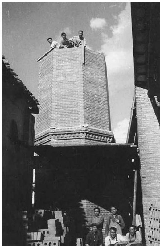
Figura 7 Ejecución del fuste de chimenea en Villarrobledo en el año 1958. Se puede ver a los trabajadores en lo alto portando el llamado taulaplom (archivo personal de Bernardo Pérez)
