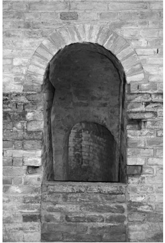
Figura 5 Entrada a la chimenea de Llauri
