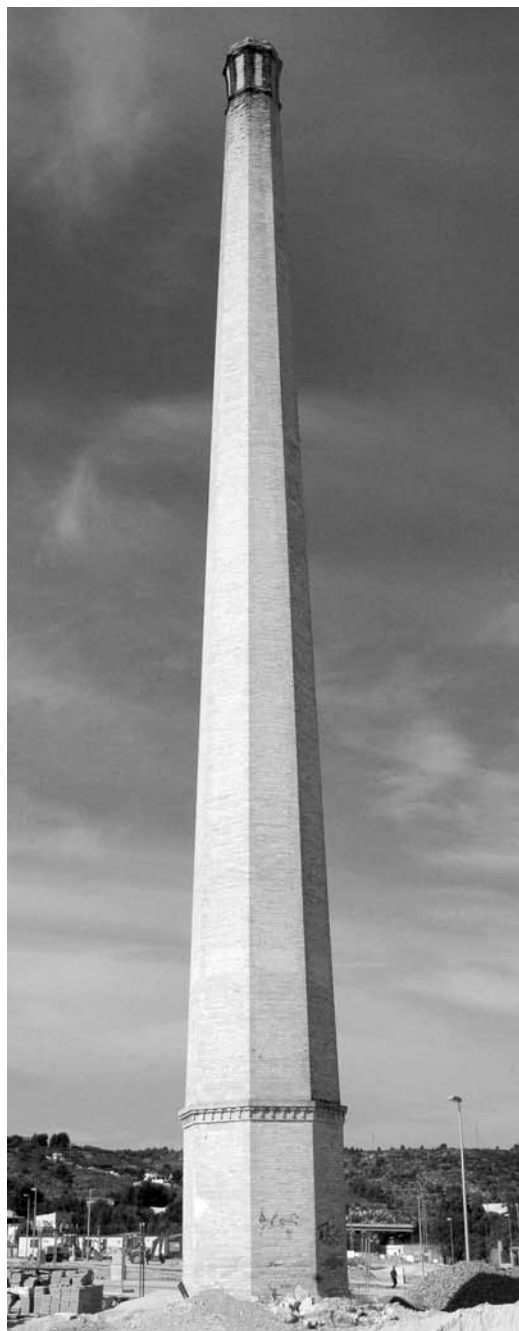
Figura 1 Chimenea fabril en Llaurí (Valencia), construida en los primeros años de la década de los 50
