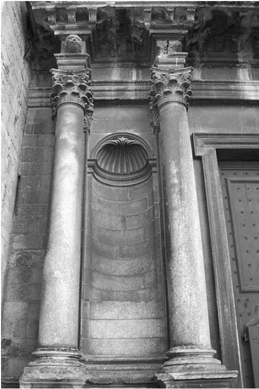
Figura 3 Fotografía del primer cuerpo de la fachada de la iglesia de San Félix de Girona (Alegre, Crous 2003). Como se observa las columnas se hicieron lisas en contra de lo citado en el contrato para la realización de la maqueta
