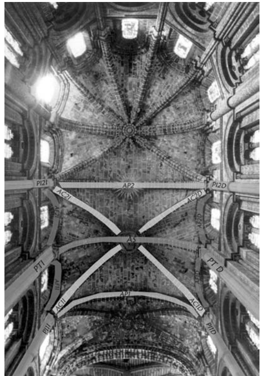
Figura 9 Bóvedas del presbiterio, señalándose los arcos y pilares para analizar la distribución de cargas
