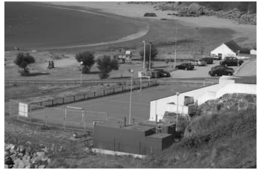
Figura 10 EDAR, en primer término, y campo de fútbol, sobre la antigua zona de dunas
