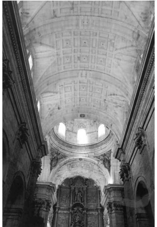
Figura 1 Bóvedas de la iglesia del Colegio del Cardenal
