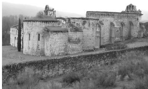
Figura 3 Fachada septentrional de la iglesia
