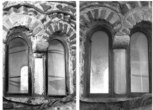
Figura 6 Stilo, Católica, material de recuperación, en las biforas de la cúpula central se pueden observar los materiales de recuperación utilizados
