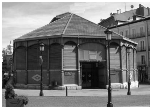
Figura 2 Vista actual del mercado del Val
