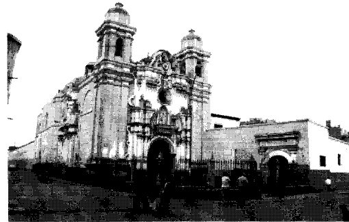
Figura 9 Ejemplos de Iglesias limeñas construidas con quincha, (torres, bóvedas, cúpula) Iglesia Sta. Clara y Las Trinitarias.
