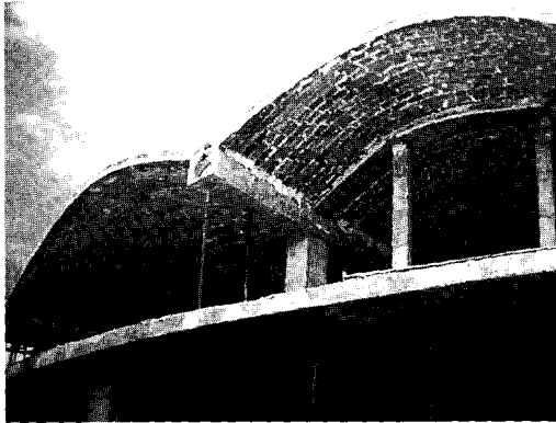
Fig. 17 Vista inferior de bóvedas conoidales
