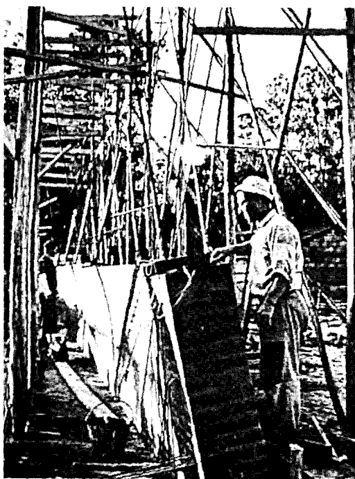
Fig. 14 Levantamiento del muro
