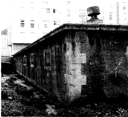
Figura 7 Depósito de Monte Alto
