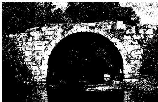
Figure 11 Ponte do Arquinho
