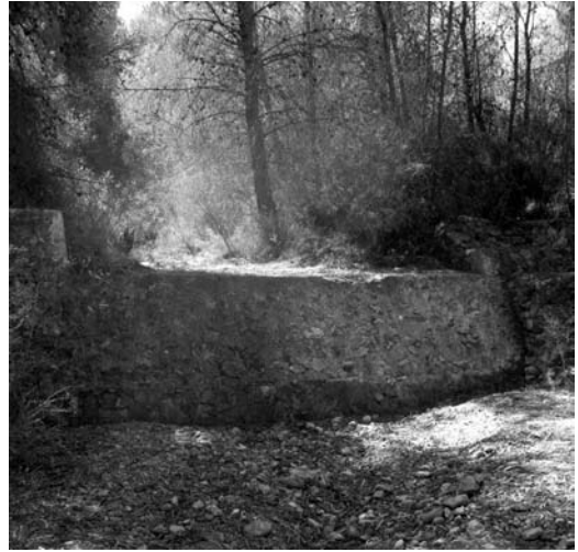
Figura 5 Azud ubicado en la rambla de Giménez(foto del autor 2013)
