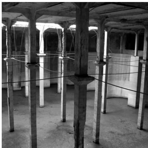
Figura 13 Interior del depósito Serna (foto del autor 2013)
