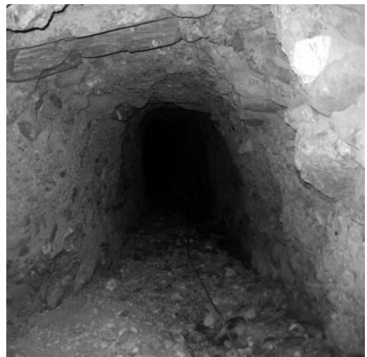
Figura 6 Interior de la galería que comunica los dos pozos(foto del autor 2013)
