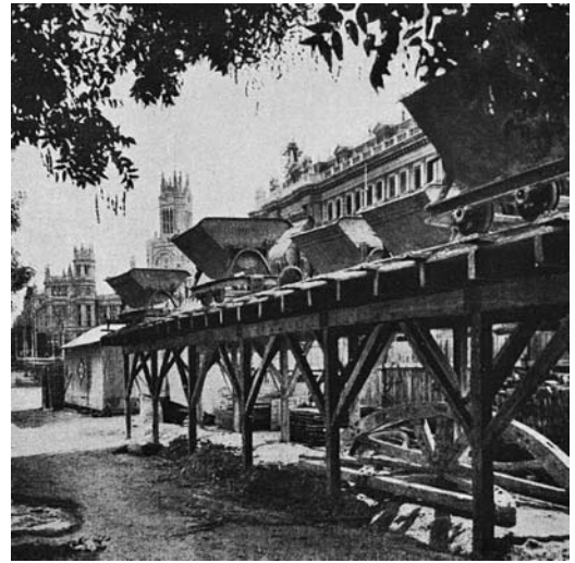
Figura 9 Muelle elevado con doble vía Decauville en el pozo de trabajo de Banco de España. (Otamendi 1924b, 6)
