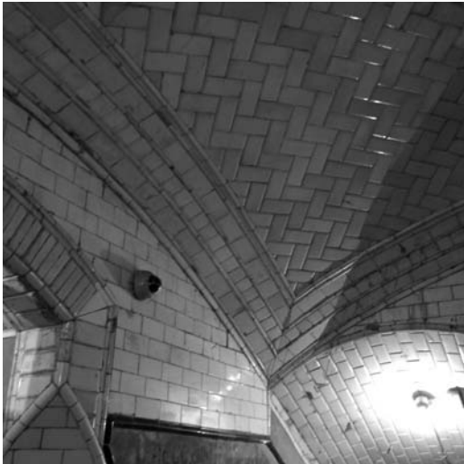
Figura 10 Encuentro de la bóveda del vestíbulo de la estación de Chamberí con las embocaduras de los pasillos de acceso a los andenes. (Foto de la autora 2012)
