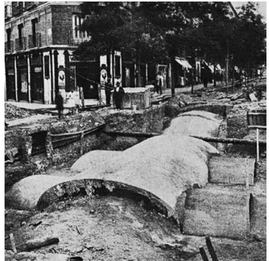
Figura 5 Fotografía de la construcción del vestíbulo de la estación de Príncipe de Vergara. En el terreno se ha preparado el molde para hormigonar la bóveda del vestíbulo (Otamendi 1924b, 10)
