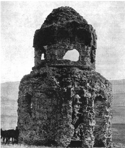
Figura 1 Construcción armenia de hormigón (iglesia en Goguba). Las placas de piedra del revestimiento han sido robadas, salvo en la parte superior (Strzygowski 1918; foto Jermakov)
