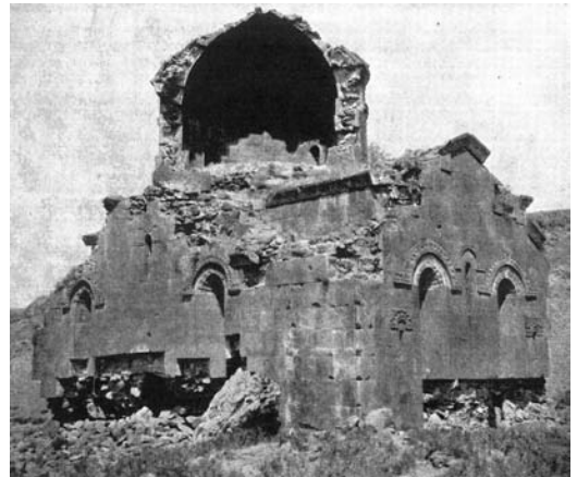
Figura 2 Iglesia del convento de Horomos en Ani. Las placas de piedra sirvieron de cimbra para la construcción de la cúpula de hormigón (Strzygowski 1918; foto Toramanian)
