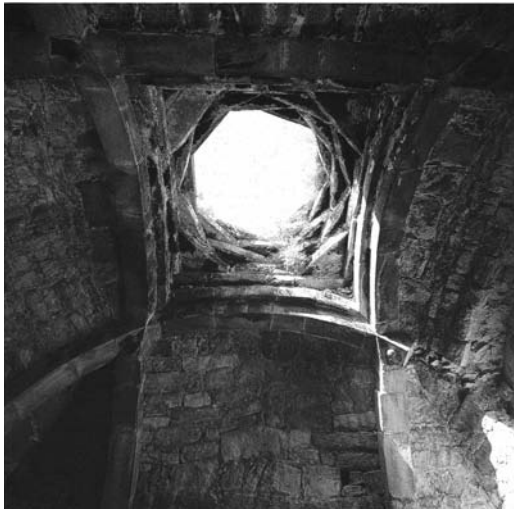
Figura 12 Arriba, Planta del gavit de Arak'eloc'vank' (Cuneo 1988); abajo, vista de la cúpula. Nótese que uno de los nervios se ha caído (Alpago Novello 1995)
