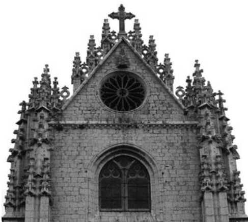
Figura 12 Remate de la fachada este, visto desde el frente, con hastial de gran pendiente (foto de los autores 2007)
