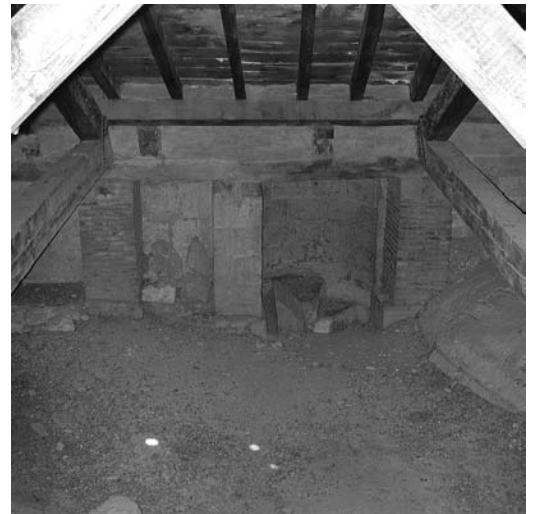
Figura 3 Pilastras de piedra y ladrillo para apoyo de la estructura de madera (foto de los autores 2003)
