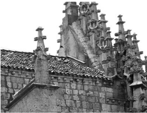
Figura 15 Vista del encuentro del remate de la fachada oeste con la fachada norte (foto de los autores 2007)
