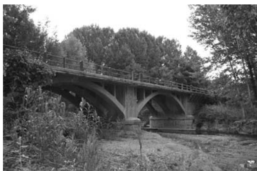
Figura 9 Puente sobre el río San Juan en la actualidad
