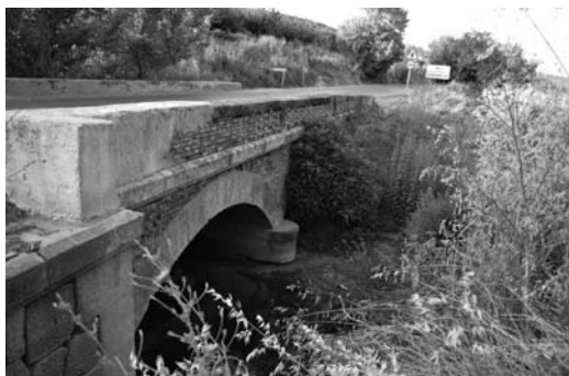
Figura 12 Pontón sobre el arroyo Guadalcotón en la actualidad (foto del autor)
