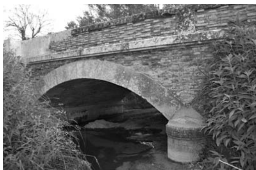
Figura 13 Pontón sobre el arroyo Guadalcotón en la actualidad. Detalles de pilas, arcos, tímpanos y pretil (foto del autor)
