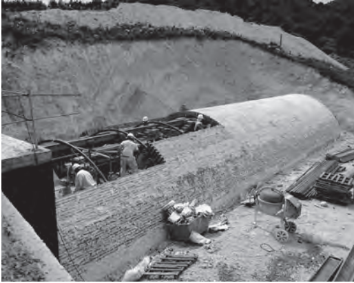
Figura 14 Cierre del cuarto de los tramos previstos. Foto: C. Martín
