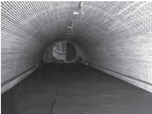
Figura 18 El interior de la bóveda, rematado. Foto: C. Martín
