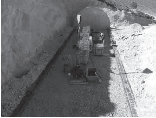
Figura 6 Arranque de la fábrica sobre la cimentación. Foto: C. Martín
