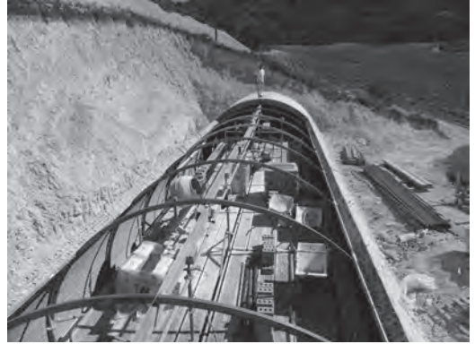
Figura 12 Primer tramo de bóveda cerrado. Foto: C. Martín
