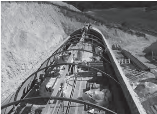
Figura 11 Proceso de cierre de los primeros tramos. Foto: C. Martín
