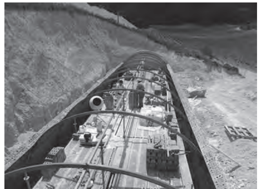
Figura 9 Construcción de la bóveda hasta el tercio de la altura. Vista desde el exterior. Foto: C. Martín
