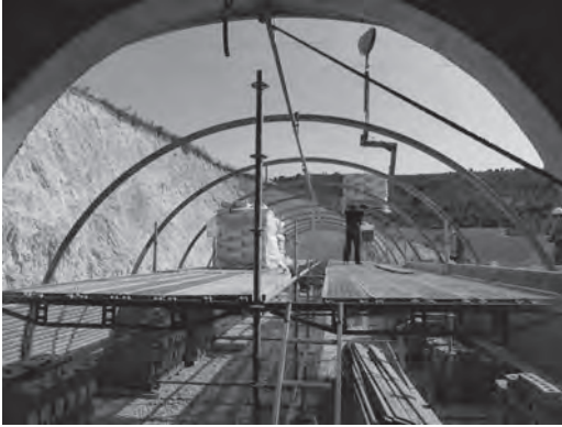
Figura 10 Construcción de la bóveda hasta el tercio de la altura. Vista desde el interior. Foto: C. Martín
