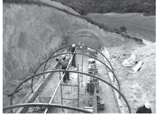
Figura 8 Instalación de las cimbras de apoyo y replanteo. Foto: C. Martín
