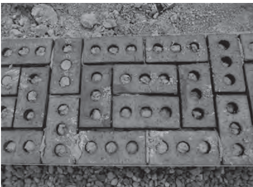
Figura 7 Aparejo del doble pie de apoyo, respetando el mismo intradós sogasoga-tizón que habría de emplearse para toda la bóveda. Foto: C. Martín
