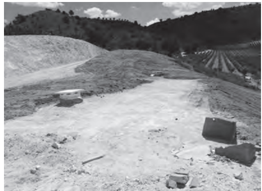
Figura 17 Vista exterior del relleno, con las tapas de ventilación de las zarcas ya instaladas. Foto: C. Martín
