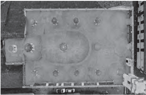
Figura 2 Quito, iglesia de Santa Clara, cubiertas (Foto de los autores)
