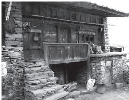
Figura 8 Fotos de la tipología de viviendas C (Autores)
