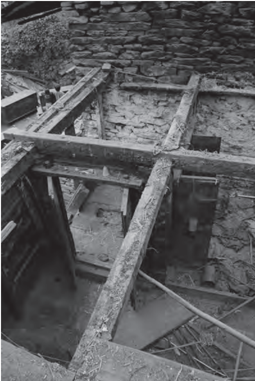
Figura 13 Foto del entramado de vigas, viguetas, tablonos y pies derechos (Autores)
