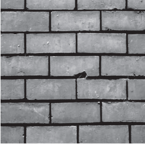
Figura 1 Fábrica de ladrillo prensado con aparejo de tizones y juntas a hueso (Autor 2001).
