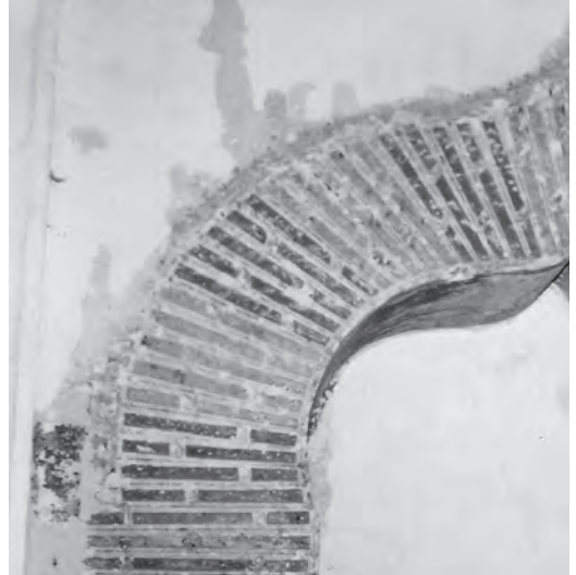
Figura 13 Aparejo fingido en el interior de una iglesia mudéjar (Autor 1998).
