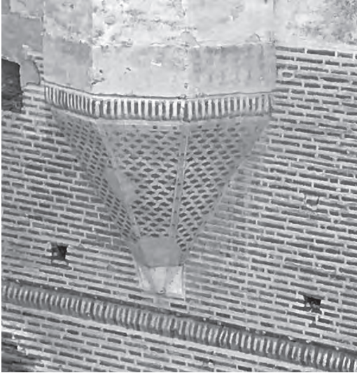
Figura 12 Castillo de Coca: motivos grecados, sardineles con aparejo fingido y fábricas con encintado (Llorente 2019)
