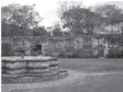
Figura 3 Restos del claustro del colegio mercedario. En primer término, la fuente. Imagen del autor
