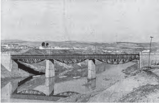
Figura 3 Puente de hierro sobre el río Guadalimar tras la reforma de 1942. (Mendizábal-Peña 1943). Biblioteca Ferroviaria. Fundación de los Ferrocarriles Españoles
