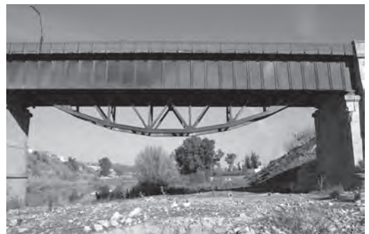
Figura 12 Disposición de los cuchillos parabólicos de refuerzo. Fotografía del autor
