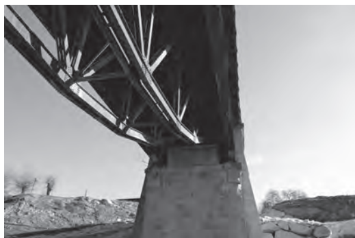
Figura 13 Detalle de los cuchillos parabólicos de refuerzo. Fotografía del autor
