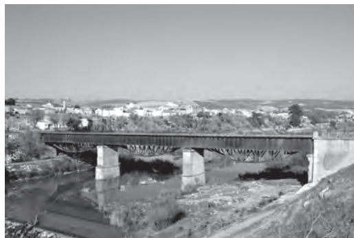
Figura 14 Vista general del puente en la actualidad. Fotografía del autor
