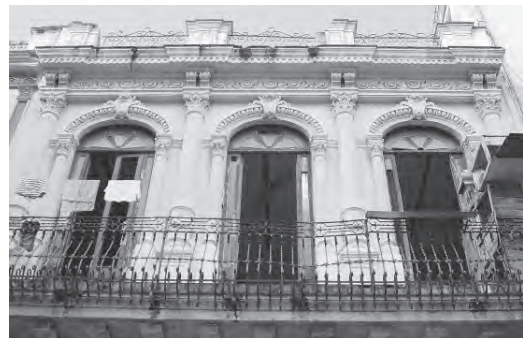
Figura 5 Fotografía detalle de fachada. Habana 412. Habana Vieja
